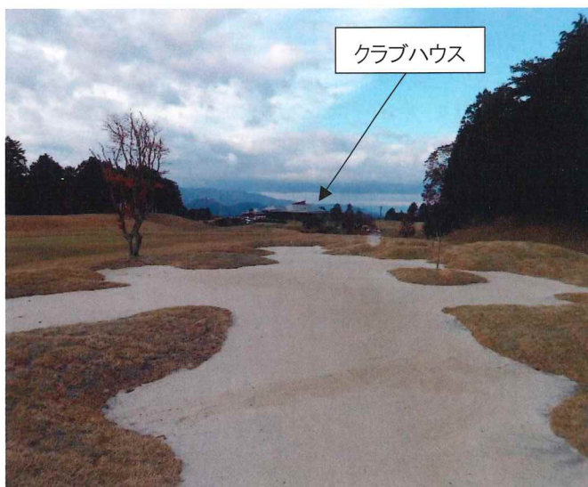
■中 No.1 第2工区 工事状況
