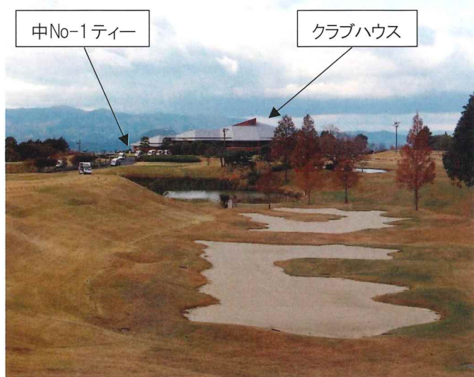
■中 No.1 第1工区 工事終了後の現況
