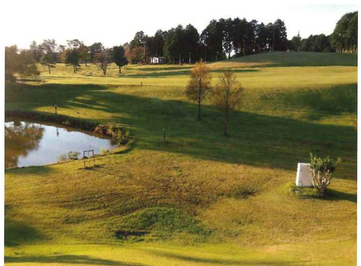
●池手前の排水不良個所。芝は発育不良により変色している。
