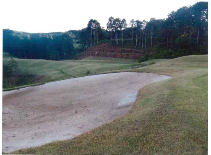
●練習用バンカーから新設フロントティーを望む。
