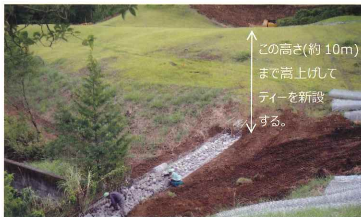
● フロン籠への石詰め作業の様子。ひとつひとつ手で詰め込む。
