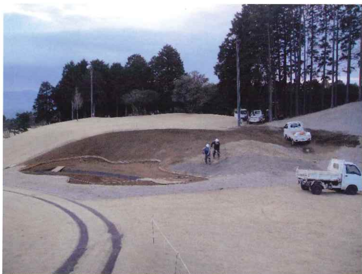
● 新設バンカーのマウンドに芝張り目砂をする作業風景。
