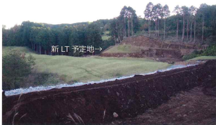
● 10m ほど高上げが完了した。正面が新 LT 新設予定地。
