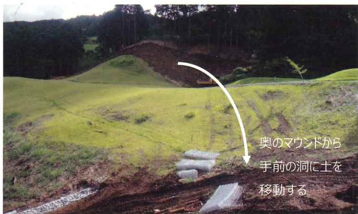
● 工事開始後の様子。正面の法面土を手前側に移動する。
