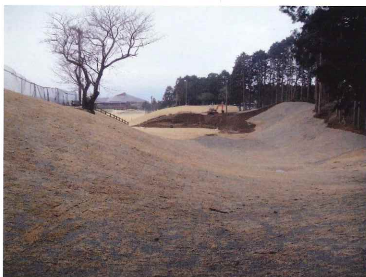
● 谷状部の芝張り目砂散布終了。バンカー工事に着手。
