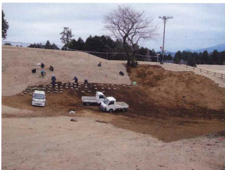
● 谷状部左側法面の芝張作業の様子。
