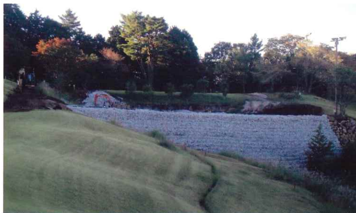
● 西 No.1 コース側から見た高上げ部。
