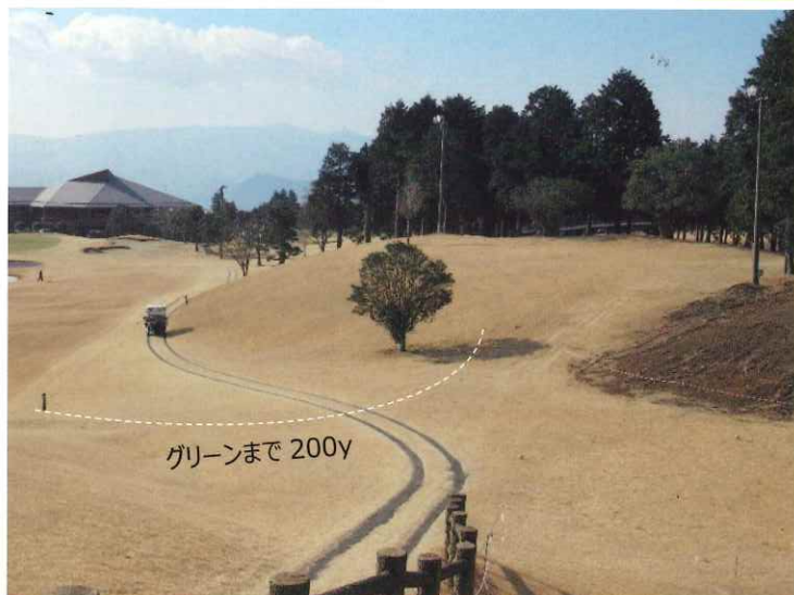
● 工事開始直後、右側林帯の伐採と造成工事開始。
